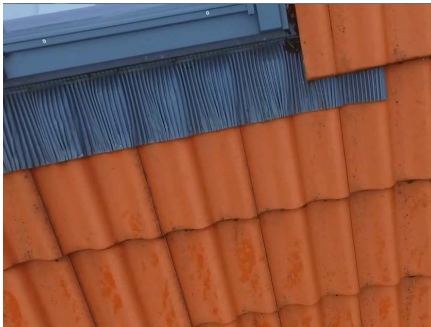
Inddækning v/ovenlys vindue
