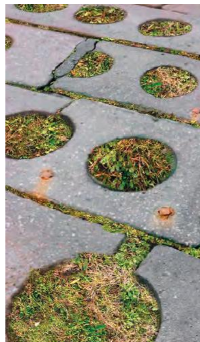
Huldæk / efter beskæring, som græsarmeringsblokke i P-arealer
