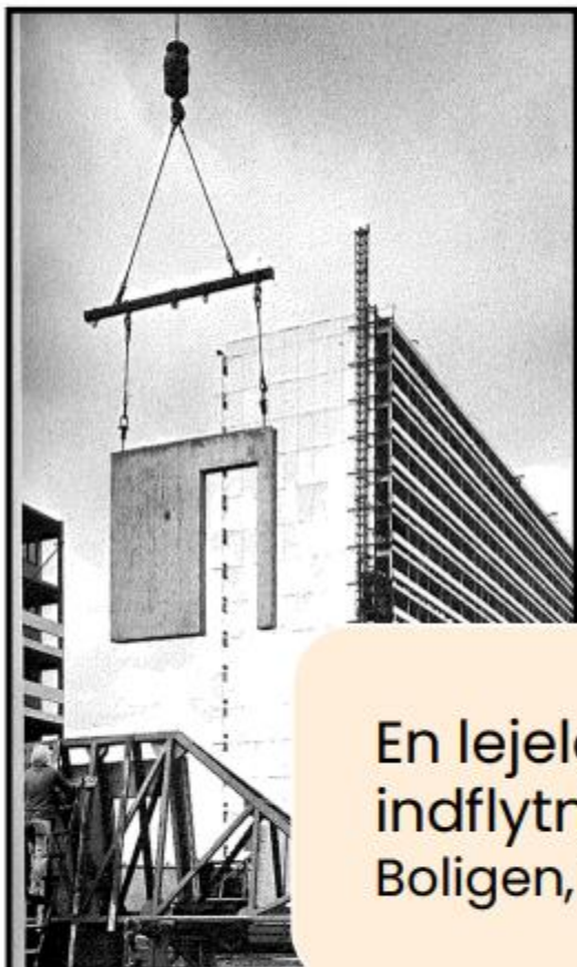
De fem bygherrer, der har forenet kræfterne for at gennemføre dette højt industrialiserede montagebyggeri er: Arbejdernes Andels Boligforening, Arbejdernes Boligselskab i Gladsaxe kommune, Fagforeningernes Boligforening for København og Omegn, Boligselskabets »Lejerboe«, Foreningen Socialt Boligbyggeri, og forretningsfører for byggeriet er »Arbejderboe«.
