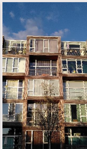
Dortheavej Prisbelønnede boliger i præfabrikerede træ- elementer
