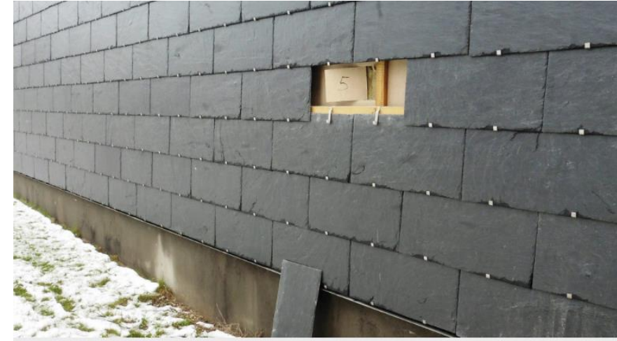
MgO plader skiftet ved ventilerede facader
