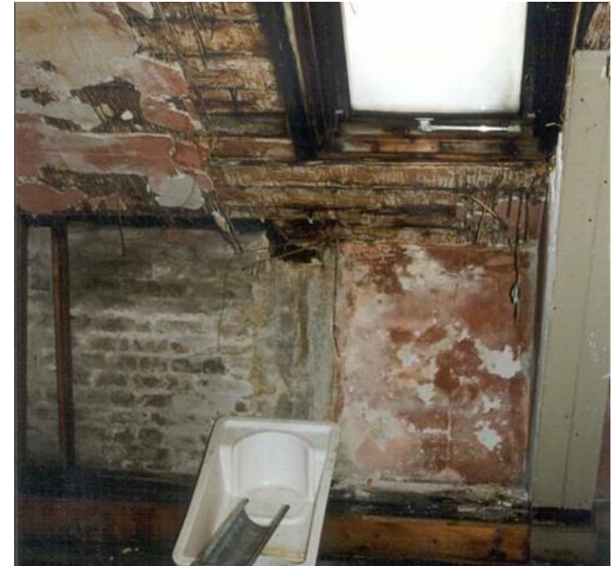
△ Vedligeholdelse og brugeradfærd
