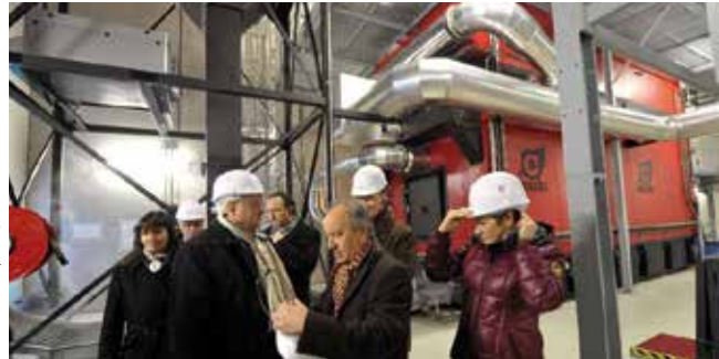
NY FJERNVARMEKEDEL TIL TRÆFLIS I 'LA GAUTHIÈRE' FOTO: FRED MARQUET
