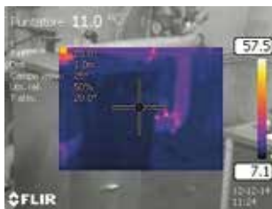
TERMOGRAFI AF VARMEVEKSLER FØR OG EFTER ISOLERING
