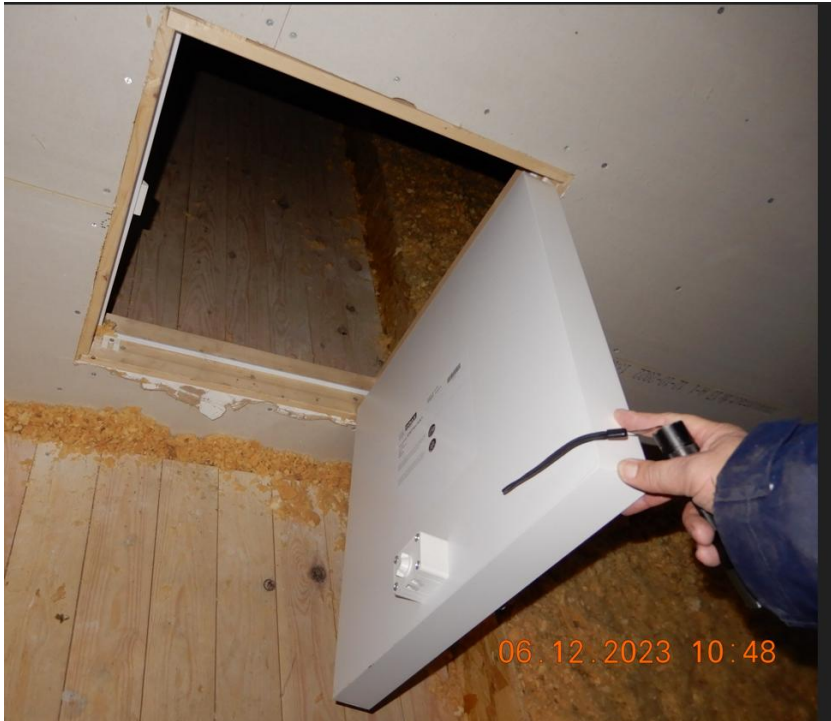
Gennemgangslem i brandmur – Gennembrændingstid?
