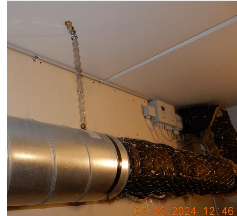
Brandisolering udført efter rullepølsemetoden
