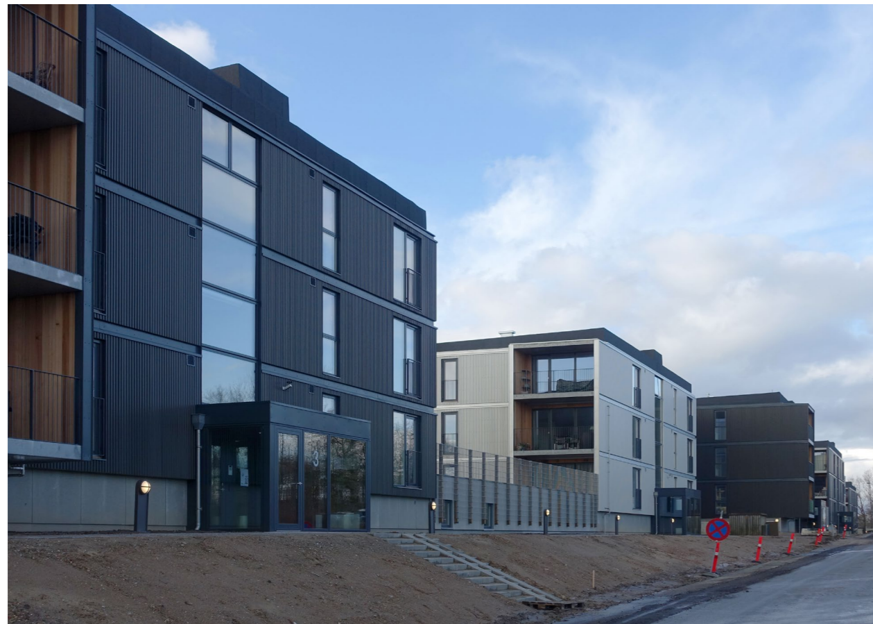
Ringgårdens Afdeling 20, Trige Parkvej, har reduceret energiforbruget med 50 pct. efter en omfattende energirenovering.
